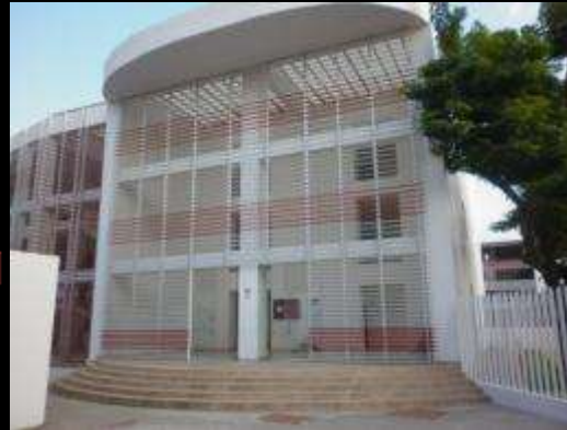
CONSTRUCCIÓN FACHADA FLOTANTE TUBRISE - CIENCIAS DE LA SALUD
